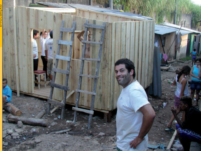
Voluntários durante construção de moradia em favela
