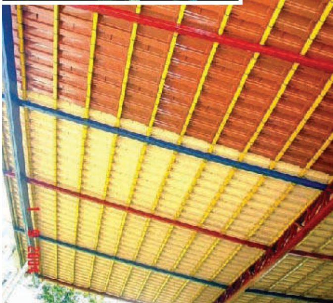
Telhas de plástico similar ao PVC feitas de garrafa PET
