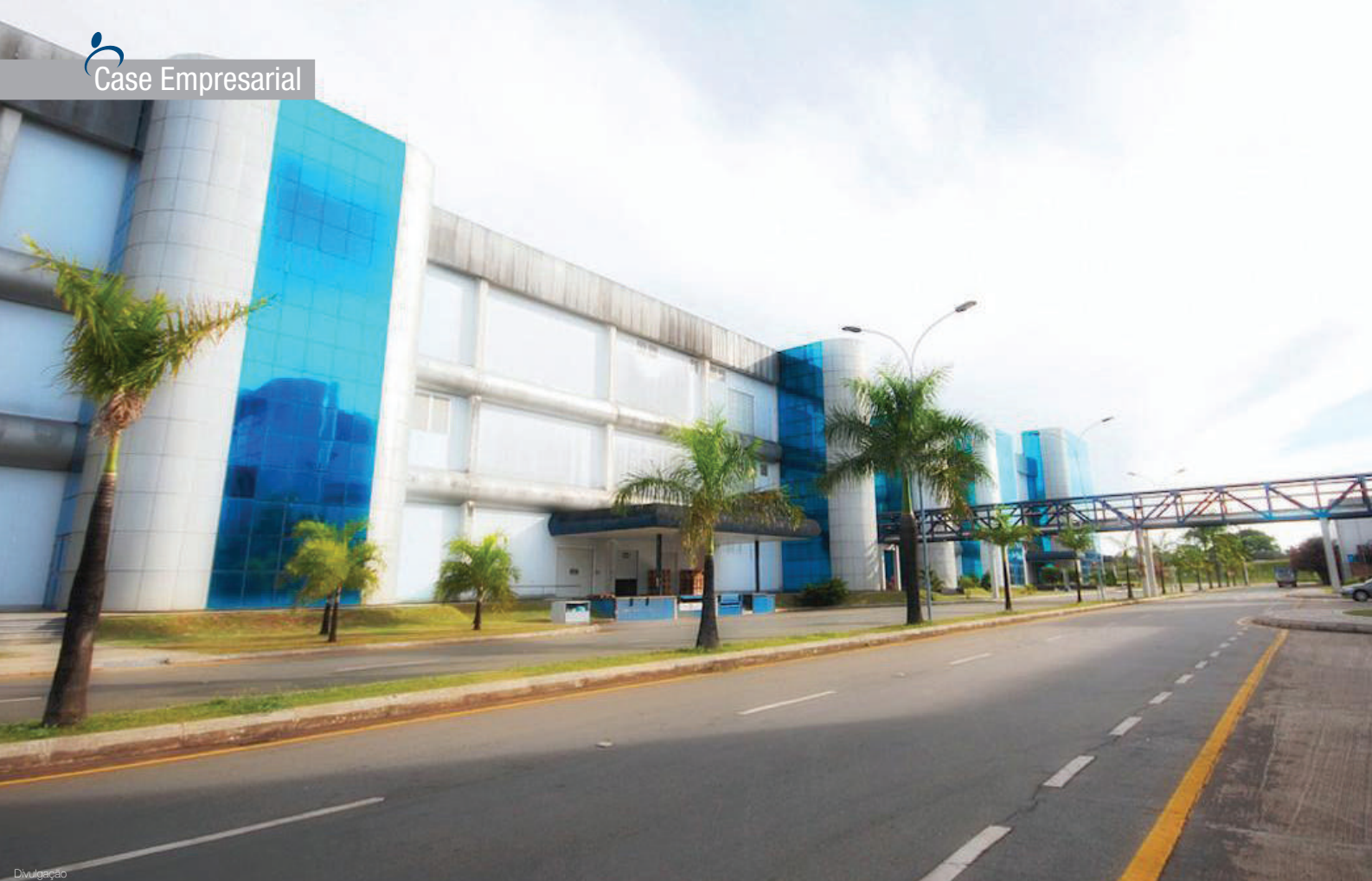
Fachada do Laboratório Teuto
