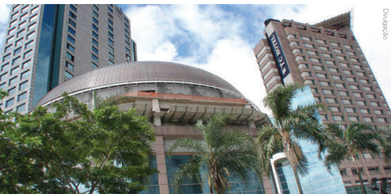
Fachada do WTC-SP
