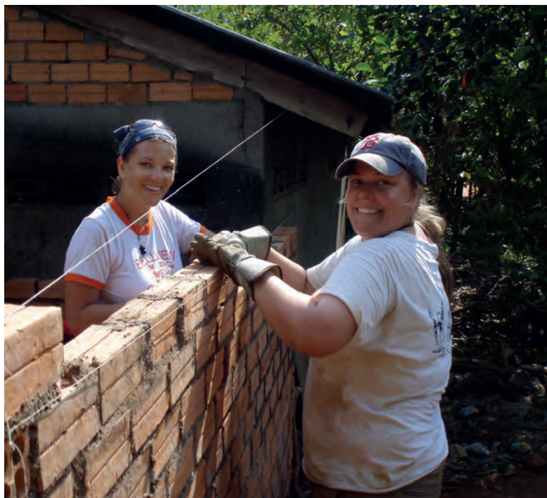
Voluntaristas trabalham na construção de banheiro em casa cambojana.
